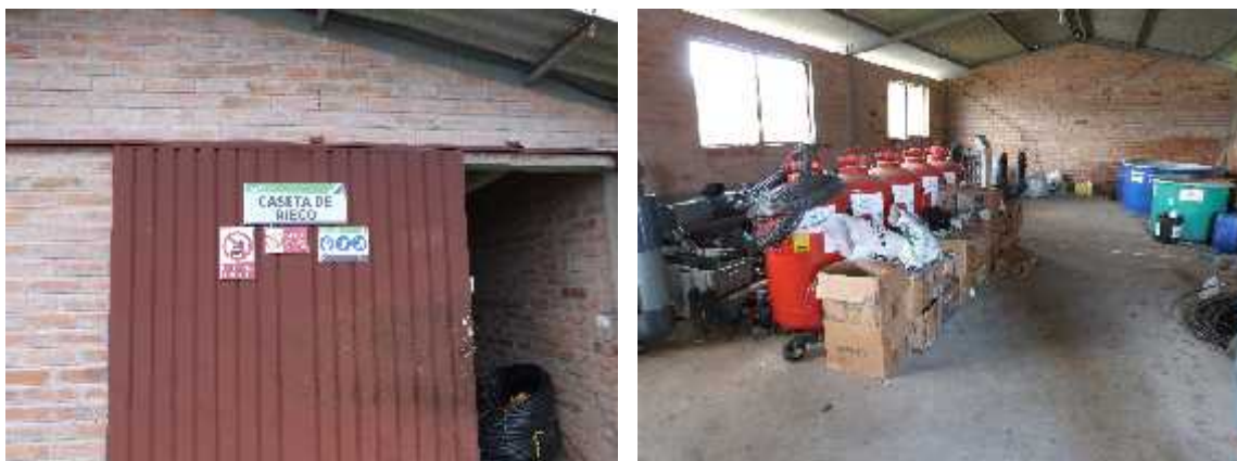
Figura 54 Fotografías de la caseta de riego
