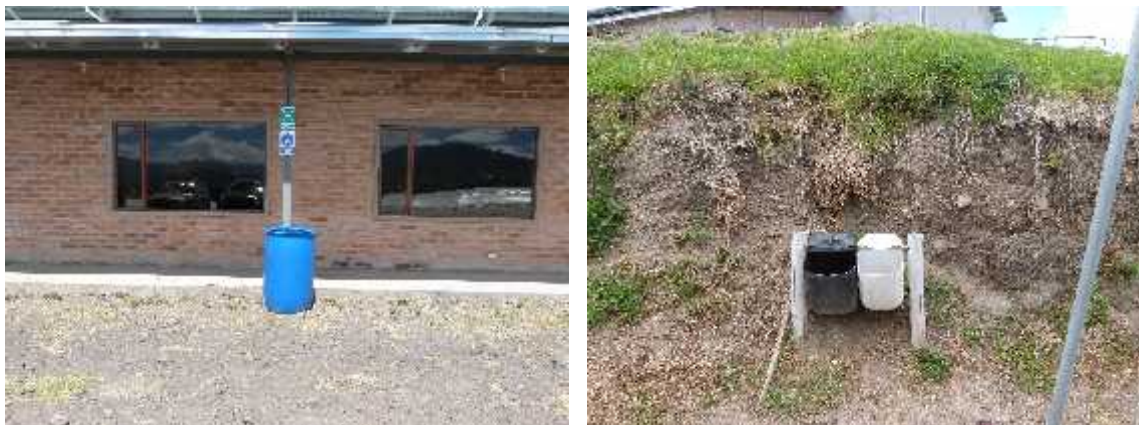
Figura 82 Fotografías del almacenamiento de desechos comunes
