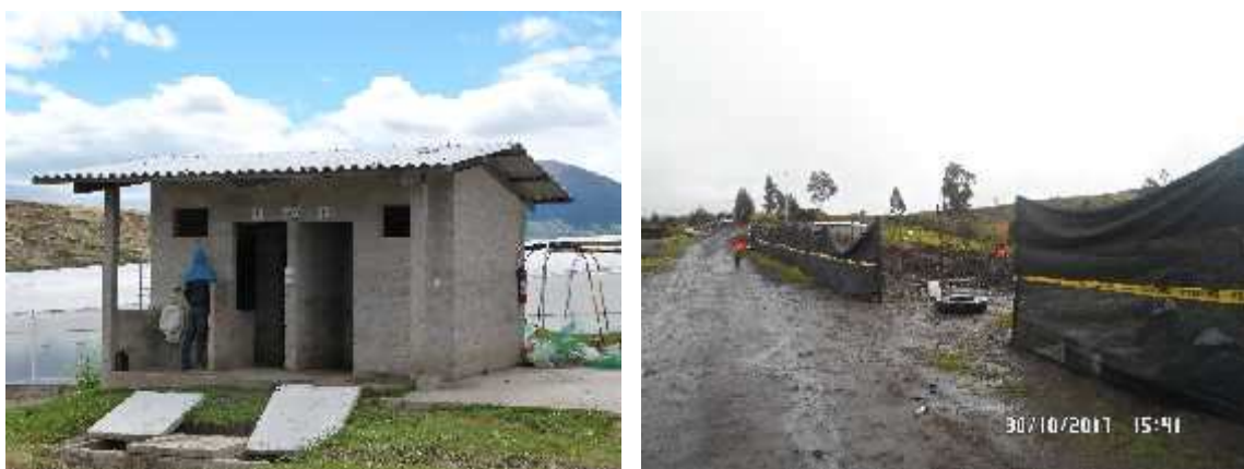
Figura 75 Fotografías de baterías sanitarias y construcción de baños duchas
