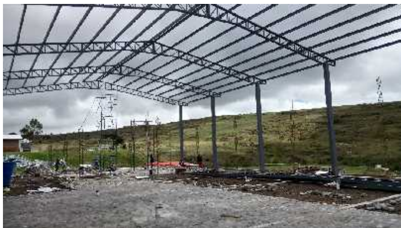
Figura 69 Fotografías del cuarto frío
